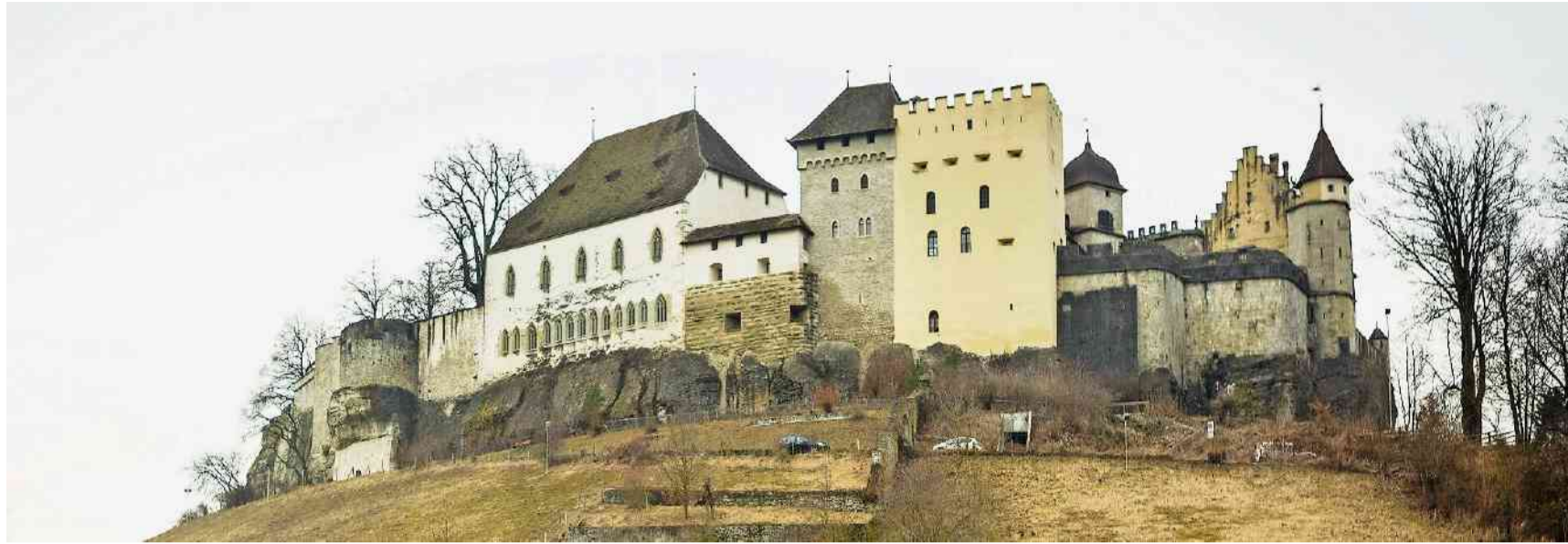
An der Fassade des Ritterhauses (weisses Gebäude mit gotischen Fenstern) sind dringende Fassadenarbeiten nötig.
